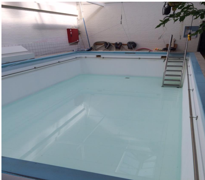
Vandet tømmes ud af det gamle varmtvandsbassin
