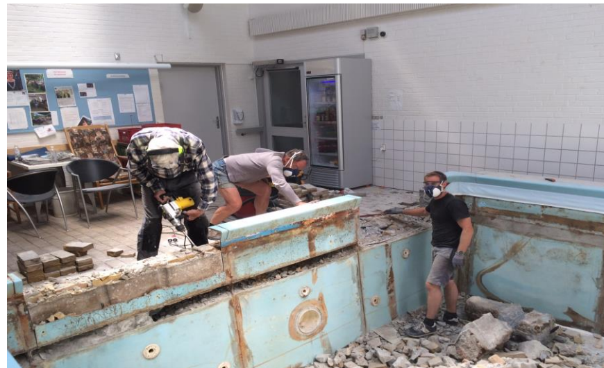
Albert, Bent og Daniel under det hårde arbejde med nedrivning af betonen. Godt gået af vores supervikarer!
